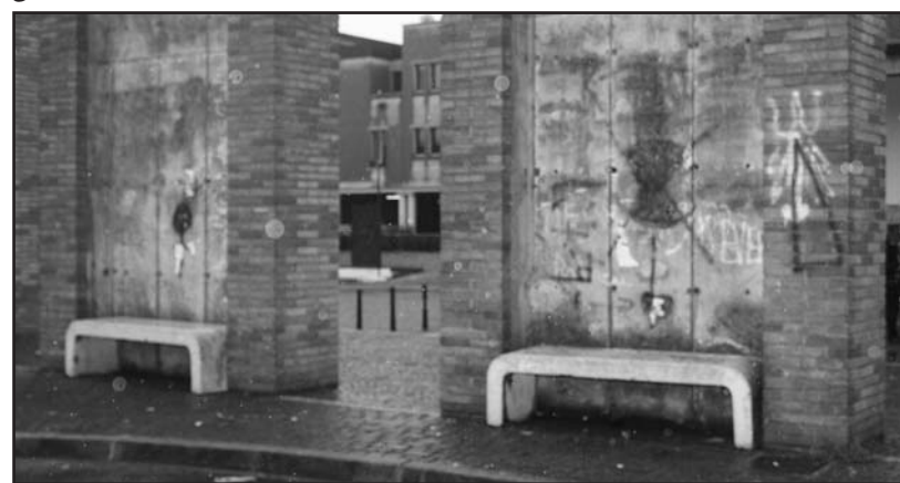
Una parte del muro in questione.
